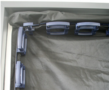
Abb. 17: Breite und schmale Klammern gesetzt
