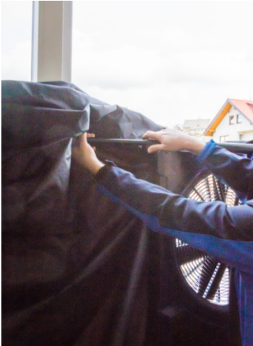
Abb. 15: Ventilatoreinheit wird mit Teleskopstange in Fenster eingespannt
