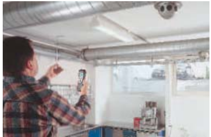
Messung der Abluft
