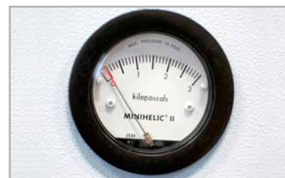
Differenzdruckanzeige zur Filterüberwachung
