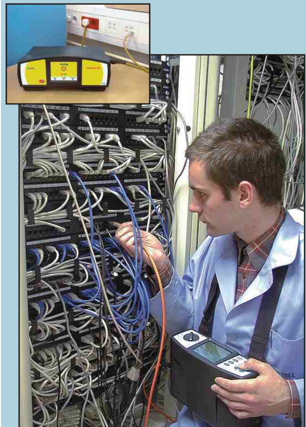
Zertifizierung von Cat 6-Anlagen Funktionsprüfungen aller Anlagen bis zu 350 Mhz
